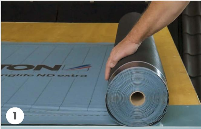
Die Dachbahnen sind waagrecht auf dem Dach auszurollen und zu verlegen. Die Überlappung der „Längsnähte“ in der Fläche muss mit dem Gefälle erfolgen und mit 15 cm überdecken. Hierfür sind die strichlierten Linien zu beachten. Die Dachbahn kann als Unterspannung freihängend oder als Unterdeckung aufliegend mit einer Zwischensparrendämmung, Schalung aus Holz bzw. Holzwerkstoffen oder einer Aufsparrendämmung ausgeführt werden.
