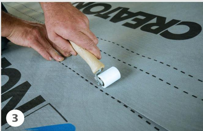
Die Verklebungen zusätzlich mit einer Rolle anpressen und fixieren.
