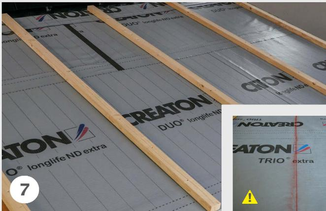
Positionieren der Konterlatten auf der Unterspannung/Unterdeckung.
