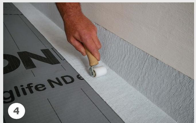
Anpressen Unterdachabschlussband mittels Handrolle an der Wand als auch der Dachbahn. Falten und Wassersackbildungen sind zu vermeiden.
