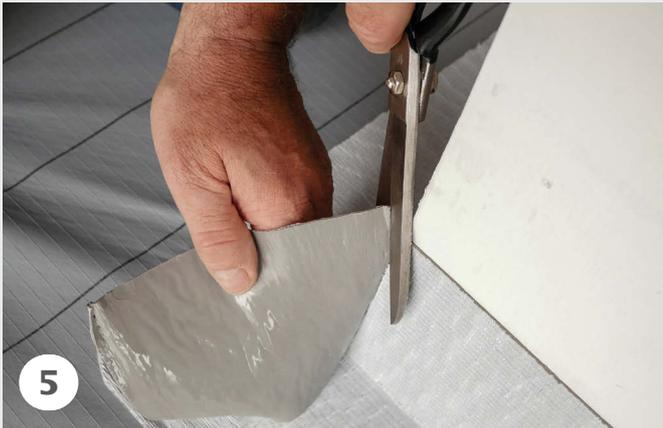
Überstehende Ecken abschneiden oder bei den obenliegenden Abschnitten einschneiden und um die Ecke kleben.
