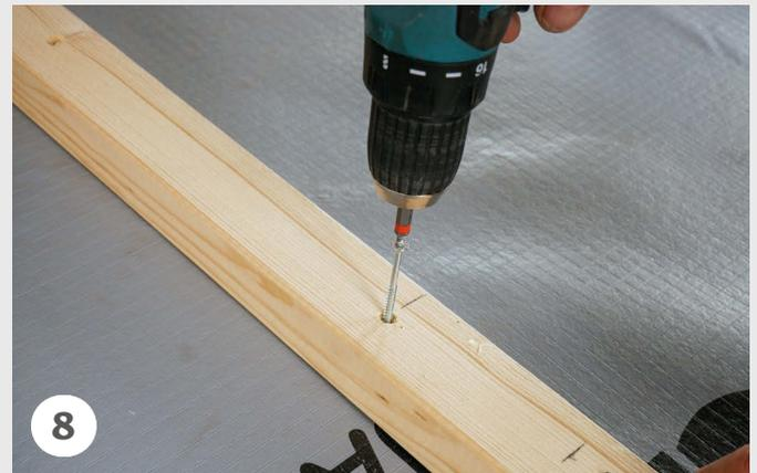
Befestigung der Konterlattung gemäß Vorgaben ZVDH (für Österreich gilt entsprechend ÖNORM, für die Schweiz entsprechend SIA-Norm) und aktuellem „Stand der Technik“.
