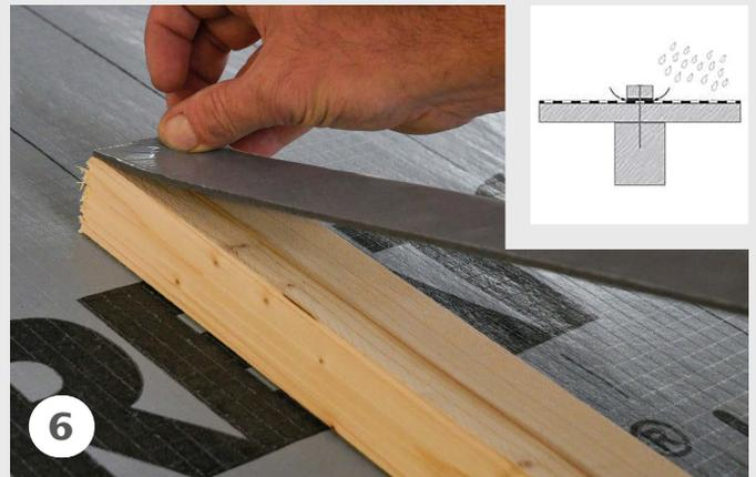
**Variante 1:** Die Konterlatten werden mit dem Nageldichtband NDB ...
