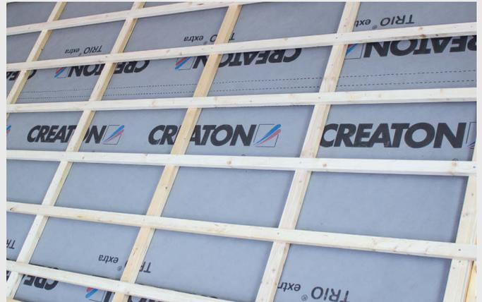
Die verklebte Unterdeckung/Unterspannung mit Nageldichtung in finaler Ausführung.
