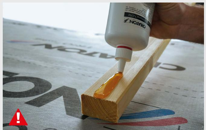
**Variante 2:** Alternativ kann auch die Nageldichtmasse NDM verwendet werden.
