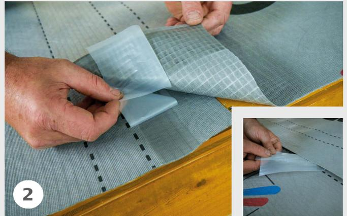
Die Dachbahnen werden mittels der integrierten Selbstklebestreifen miteinander verklebt. Ein gleichzeitiges Abziehen beider Schutzfolien ist zu empfehlen. Die Verarbeitungstemperatur für alle Dachbahnen liegt bei +5 °C bis +40 °C.
