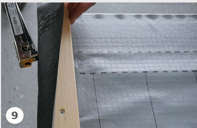
Am Ortgang Dachbahn an der Konterlatte hochführen, fixieren und den Überstand abschneiden.
