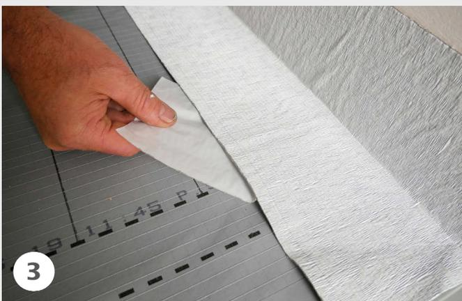
Anpressen der oberen Hälfte des Unterdachabschlussband UAB an der Wand. Folie an der unteren Hälfte des Unterdachabschlussband UAB abziehen und auf der Dachbahn ankleben.
