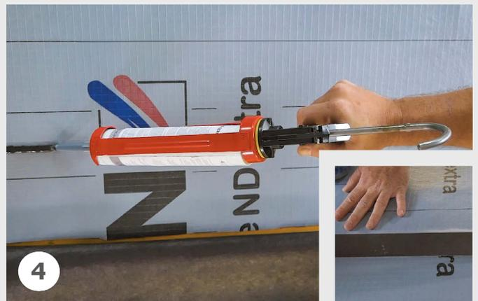
**Variante 1:** Querstöße werden unter den Konterlatten positioniert und mit dem Spezialkleber SKL verklebt.
